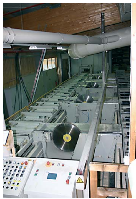
Fünf Kappsägen längen die Balken gemäß Auftrag ab
